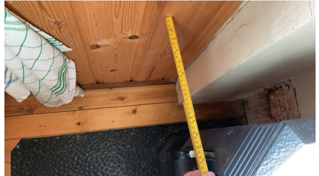
Avstand til brennbart materiale på vegg er for nært
