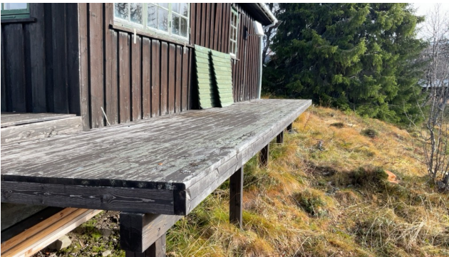
Manglende rekkverk
