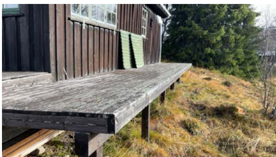
Manglende rekkverk
