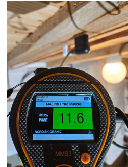
Fuktmåling i bjelkelag i teknisk rom.
