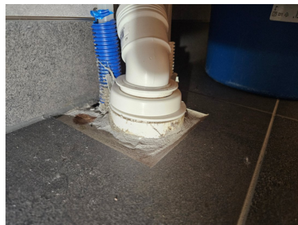
Rørgjennomføring i gulv
