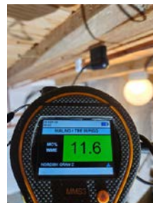
Fuktmåling i bjelkelag i teknisk rom.
