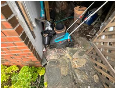
Noe synlig utvendig fuktsikring.
