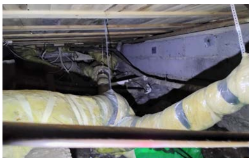
Bilde av krypkjeller
