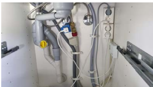
Kontroll av røropplegg under oppvaskkummen.
