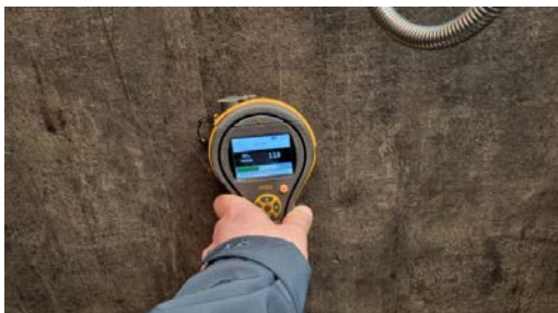
Fuktmåling i vegger, ingen unormale fuktverdier ble registrert.
