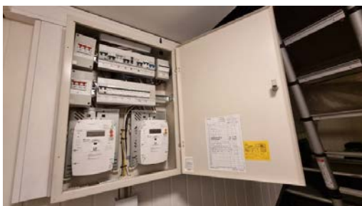
Kontroll av el-skapet.
