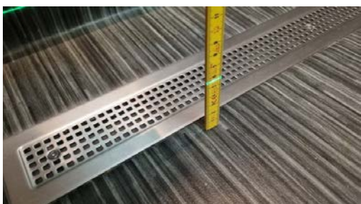
Kontroll av fall til sluk.
