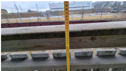
Måling av høyden på rekkverket.
