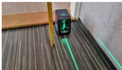
Kontroll av fall til sluk.
