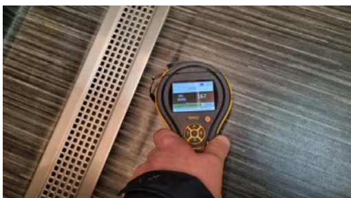
Fuktmåling i gulvet, ingen unormale fuktverdier ble registrert.
