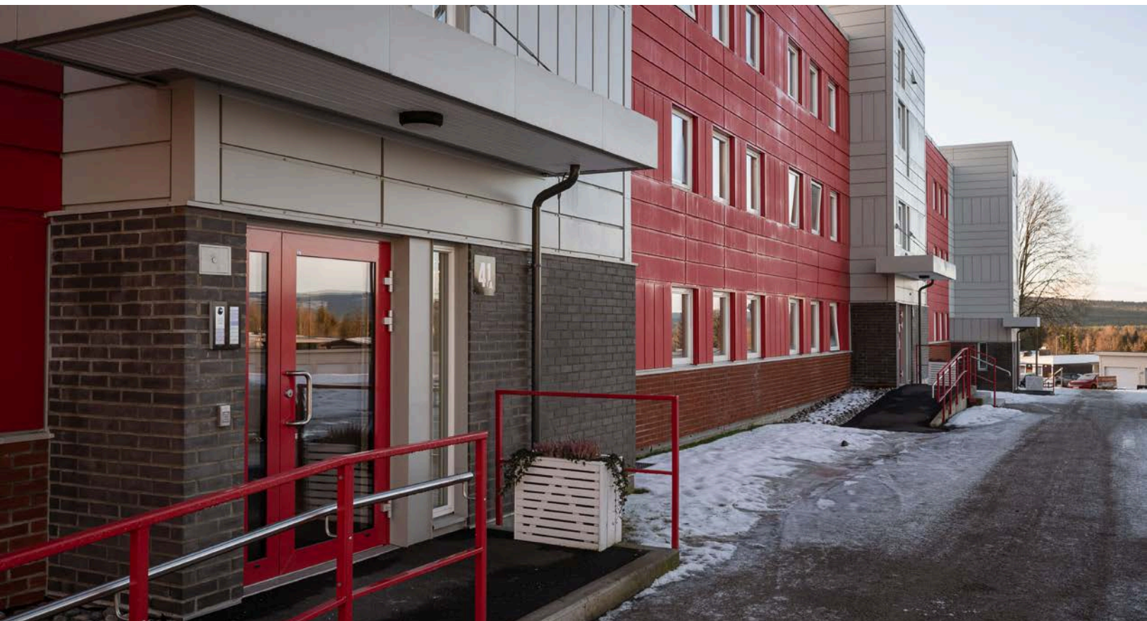
Leilighetsbyggets inngangsparti med adkomst til felles oppholdsrom med heis og trapper.
