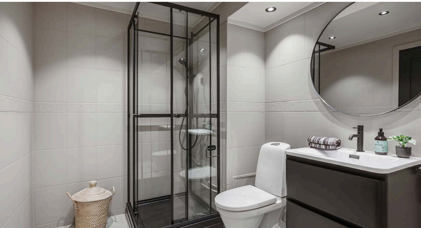
Badet er malt med våtromsmaling på gulv og vegger og det er varmekabler i gulvet.
