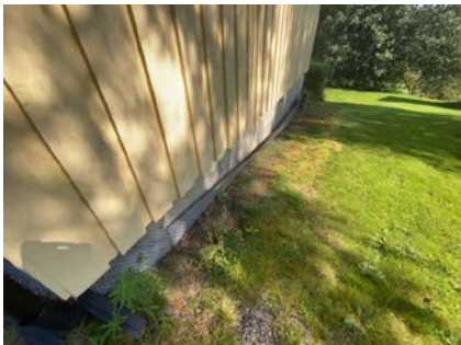
Fuktsperre på tilbygg
