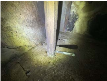
Godt synlig fukt på mur mot terreng "grovkjeller"
