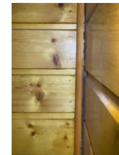
Vegg i våtsone- en plastfolie kan synes bak panel
