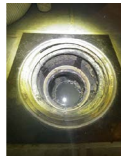
Tettesjikt kan ikke verifiseres i sluktypen.
