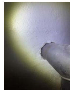
Gammeldags røykrørsinnføring
