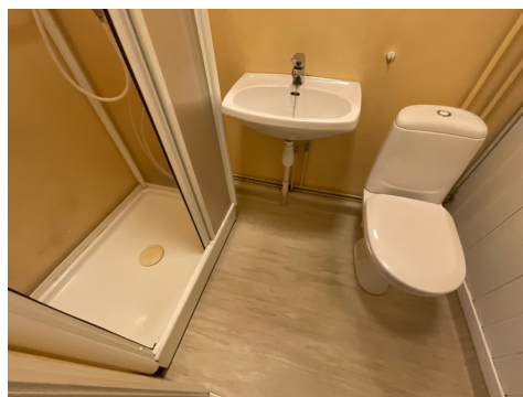
LEILIGHET 2 - 1. ETASJE. H0102 > BAD
