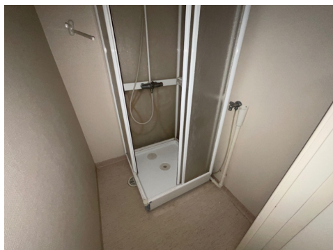
LEILIGHET 3. - 3 ETASJE. H0201 > BAD
