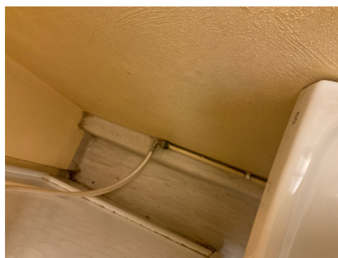
LEILIGHET 3 - 2. ETASJE. H0201 > BAD/VASKEROM
