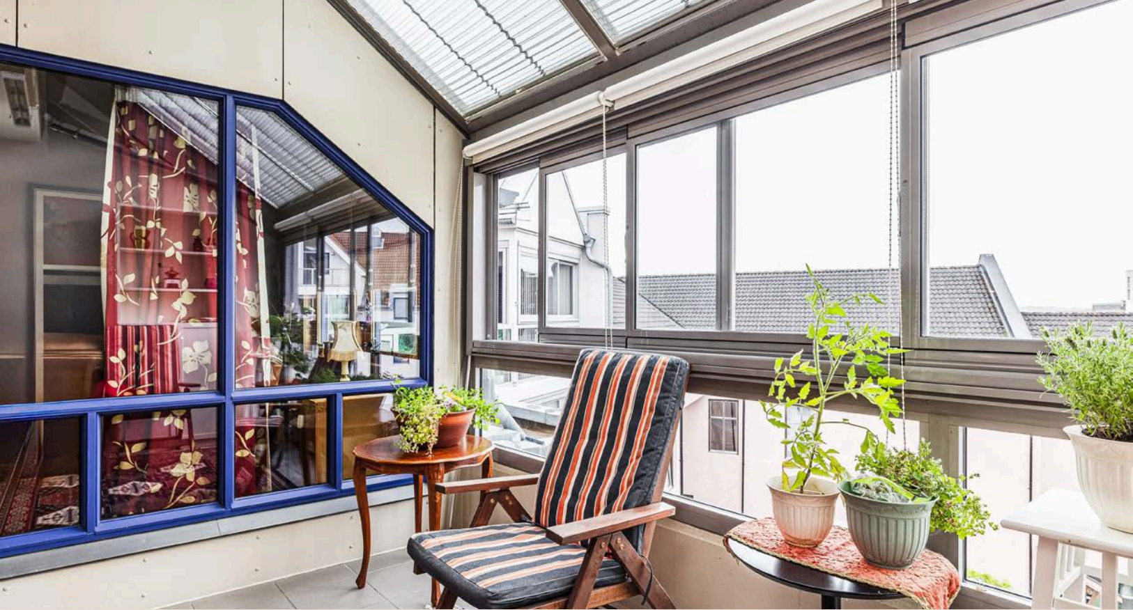
Balkongen har flislagt gulv, vindusflater som kan skyves til siden og store takvinduer som slipper inn rikelig med lys. Det er også montert innvendig solskjerming.
