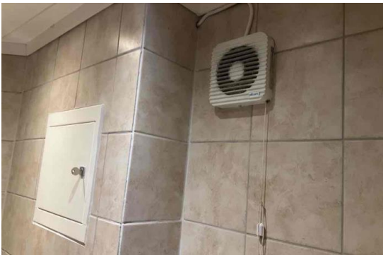
Avtrekk i vegg.
