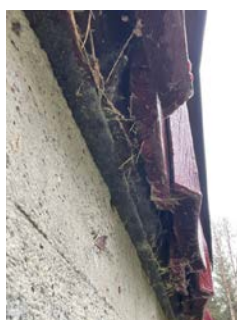
Manglende lufting/vedlikehold av kledning
