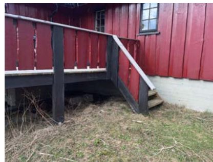
Trapp opp til veranda.
