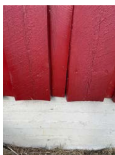
Manglende lufting/vedlikehold av kledning
