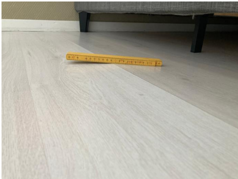
Laminatgulv har reiste skjøter.
