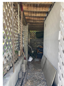
Utvendig bod med delvis åpent tak og vegger.
