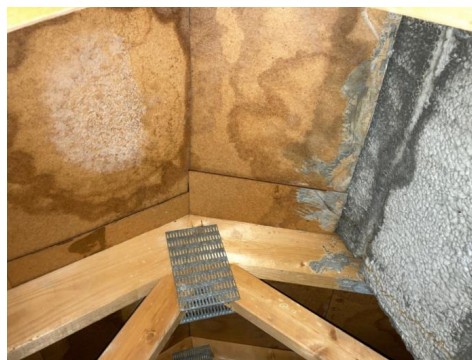
Fuktmerker ved gjennomføring av pipe.
