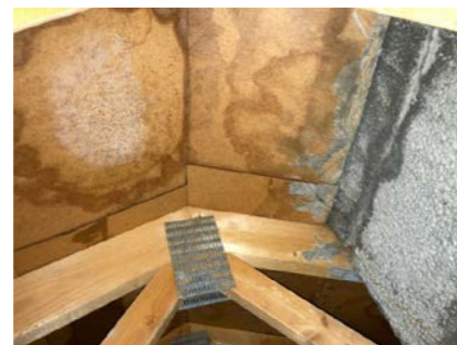
Fuktmerker ved gjennomføring av pipe.
