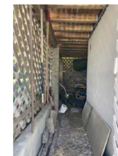
Utvendig bod med delvis åpent tak og vegger.
