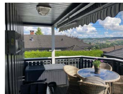
Delvis overbygget veranda.
