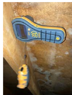
Fuktmerker ved gjennomføring av pipe.
