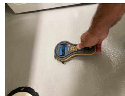
Ved fuktsøk ble det ikke avdekket unormale verdier.
