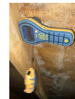
Ved fuktmåling i takverk, ble det ikke avdekket unormal fukt på befaringstidspunktet.
