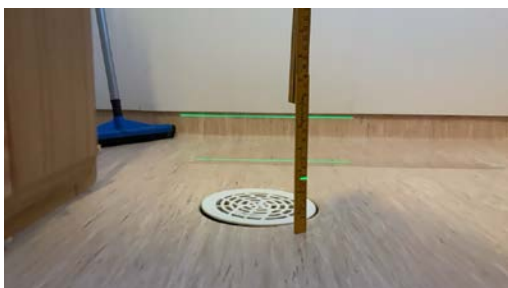
Målt fall til sluk: 16mm
