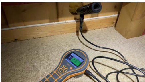
Hulltaking utført fra tilstøtende rom.
