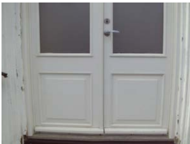
Nyere tofløyet ytterdør.
