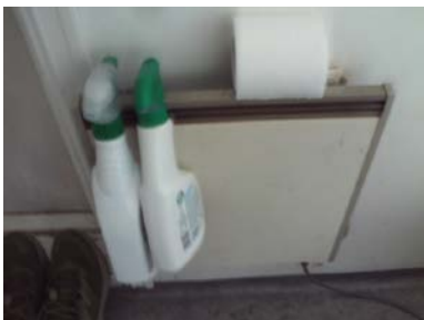
Panelovn som varmekilde.
