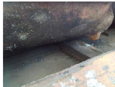
Deler av undertekking med sløyfer og lekter
