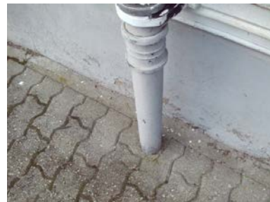
Takvann er ledet bort i fra grunnmur.
