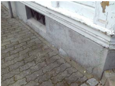
Deler av grunnmur.
