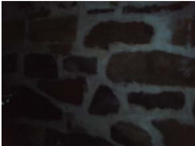
Tykke murvegger av steinblokker.
