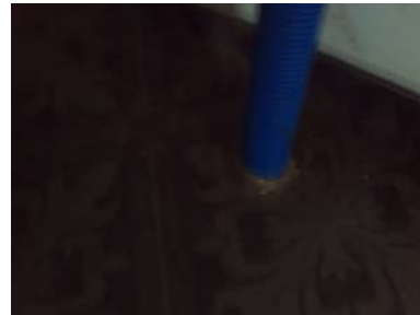
Usikker rørgjennomføring i gulvet
