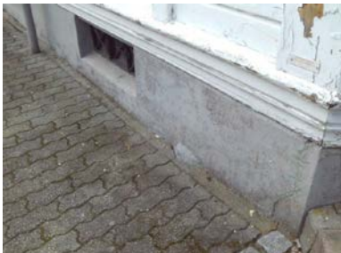
Deler av grunnmur.
