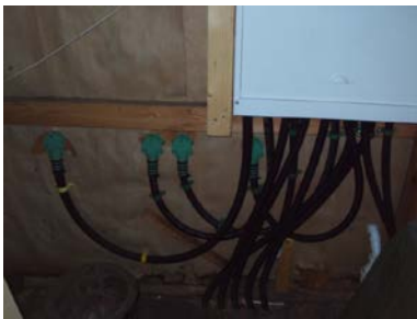
Fuktmåling i svill på kott
