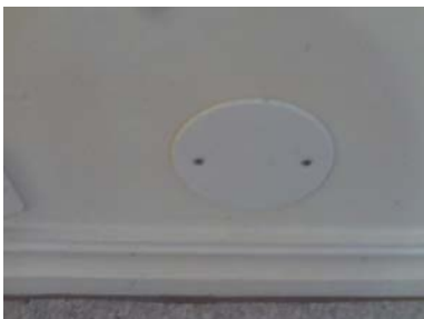
Hulltaking fra gangen mot dusjhjørne.
