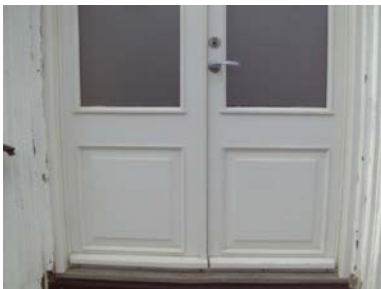
Nyere tofløyet ytterdør.
