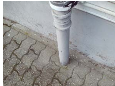
Takvann er ledet bort i fra grunnmur.
