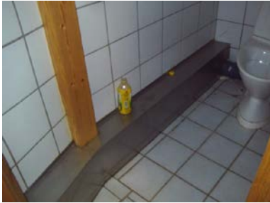
Deler av ene toalettrom i kjeller
