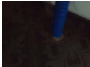
Usikker rørgjennomføring i gulvet
