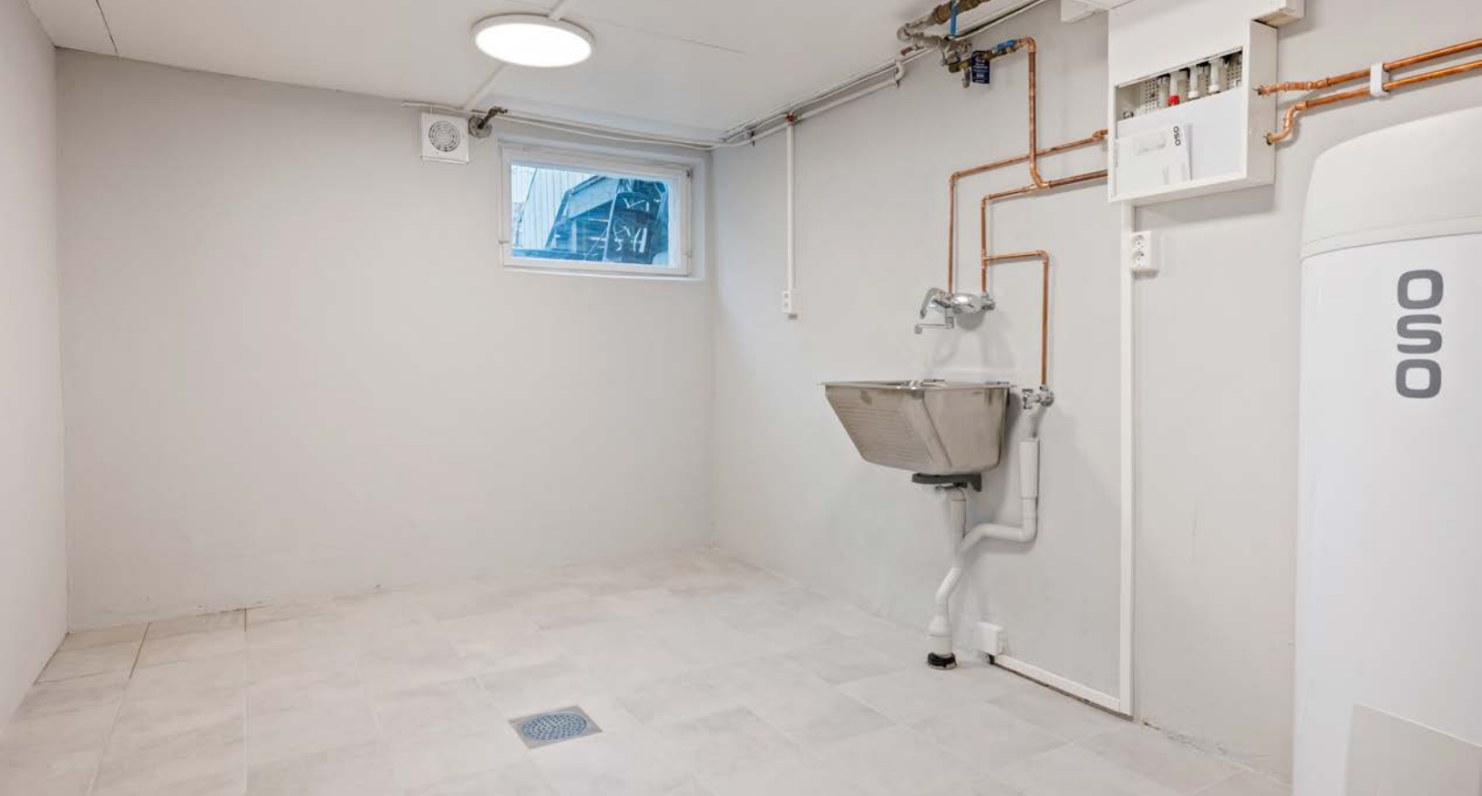
Praktisk vaskerom med utslagsvask og varmekabler i gulv
