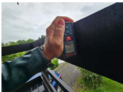
Rekkverk er målt til ca.90 cm.
