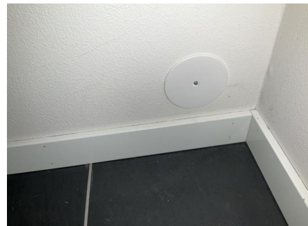
Dekkløkk montert etter hulltaking
