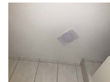
Avtrekk ble testet med papirark
