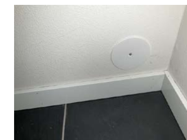
Dekkløkk montert etter hulltaking
