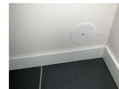
Dekkløkk montert etter hulltaking
