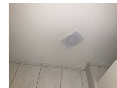
Avtrekk ble testet med papirark
