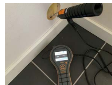
Fuktmåling med måleresultat under 8 % (vektprosent i treverk)
