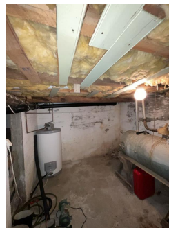
Teknisk rom med åpen isolasjon i himling
