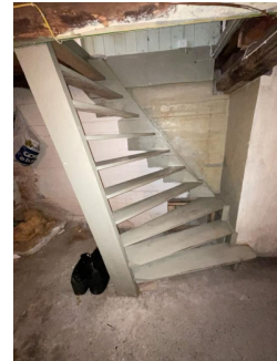
Trapp sett fra kjeller og teknisk rom
