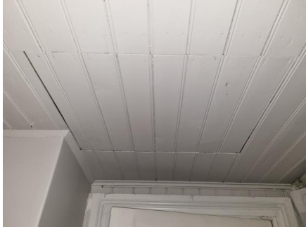
Luke til kryploft i gang på loft
