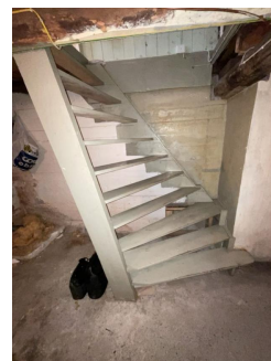
Trapp sett fra kjeller og teknisk rom
