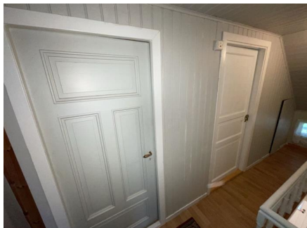
Dører til soverom 2, soverom 1 og kott sett fra gang
