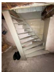
Trapp sett fra kjeller og teknisk rom
