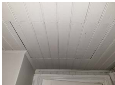
Luke til kryploft i gang på loft
