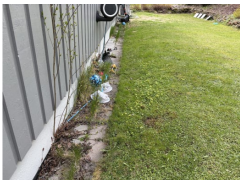
Terrenget heller inn mot grunnmurskonstruksjonen.
