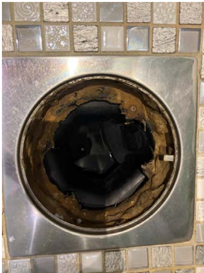
Sluket er et plastsluk og ingen tegn på skader blir registrert
