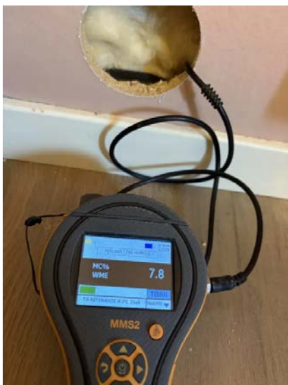
Undersøkelsen viser ingen tegn til skader eller fukt i konstruksjonen.
