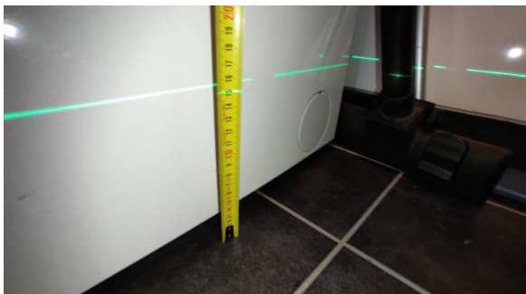
Kontroll av fallforhold.
