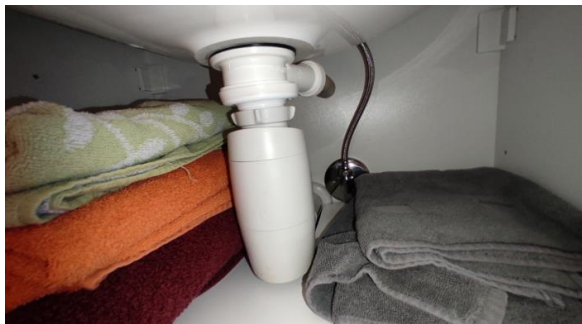
Kontroll av røropplegg.
