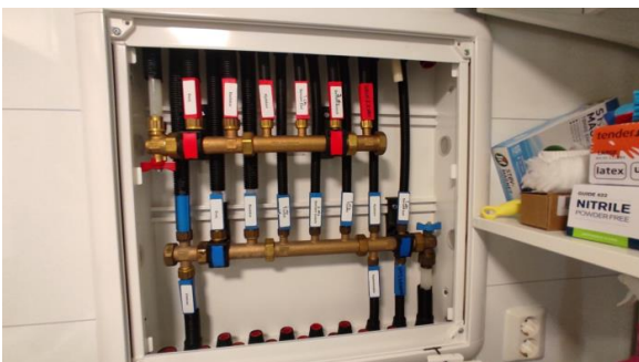
Kontroll av rørskap.
