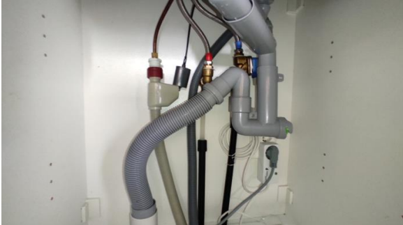
Kontroll av røropplegg.
