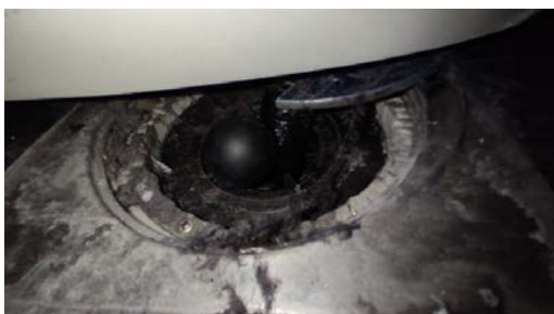
Kontroll av sluk.
