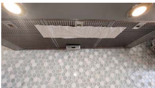
Test av avtrekket.
