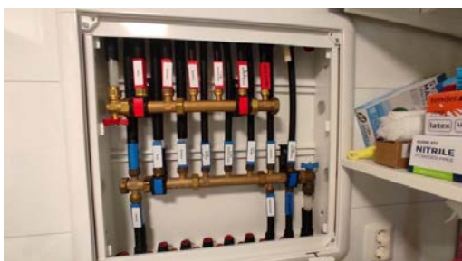
Kontroll av rørskap.
