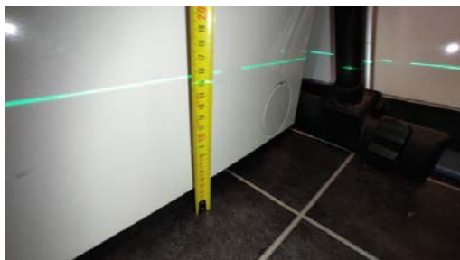
Kontroll av fallforhold.
