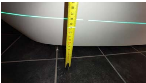
Kontroll av fallforhold.
