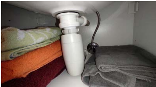
Kontroll av røropplegg.
