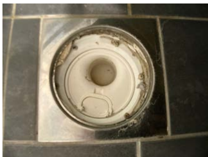
1. ETASJE > BAD - 8,9M2
