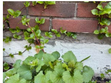
Noe sprekker i betongen.
