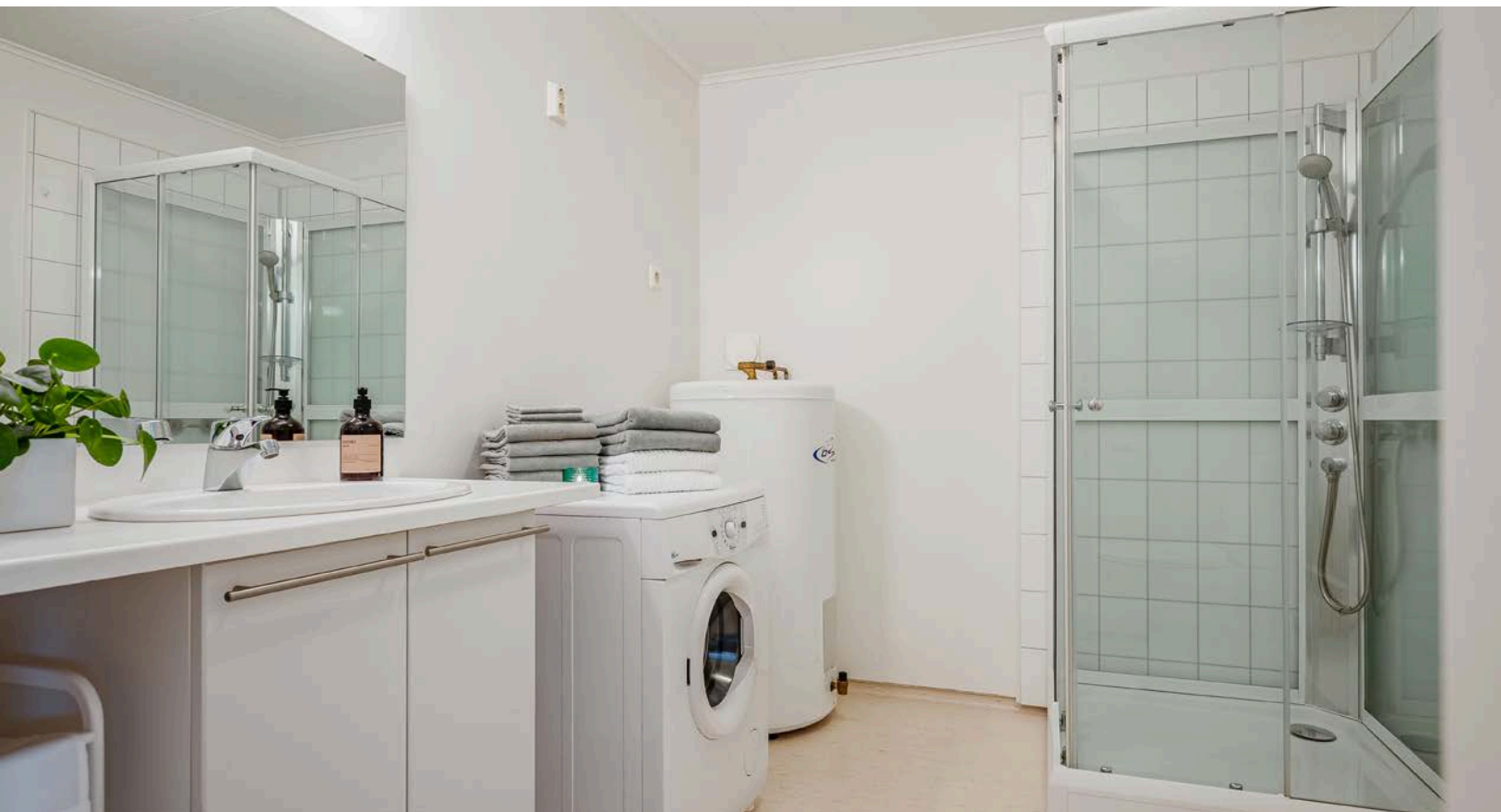
Badet i boligen er romslig med dusjkabinett. Ettgreps blandebatteri og opplegg til vaskemaskin.
