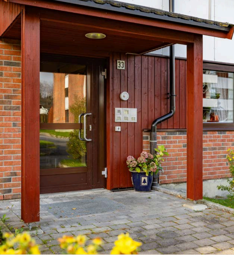
Hyggelig overbygget inngangsparti belagt med belegningsstein.
