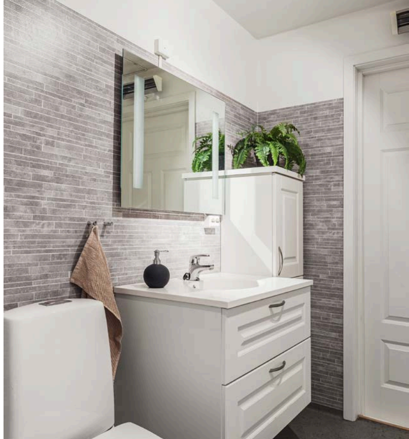
Baderommet har belegg på gulv, våtromsbelegg på veggene og mekanisk avtrekk med utkast til friluft.
