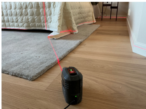
Nivellering soverom, avvik ca. 15-30 mm
