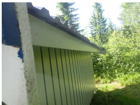
Manglende takrenne/nedløp.
