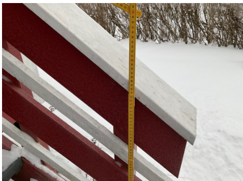
Rekkverk utv. trapp
