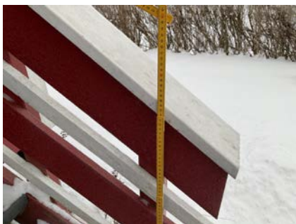
Rekkverk utv. trapp
