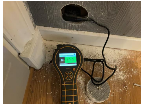
Fuktmåling i konstruksjonen mot dusjsonen.
