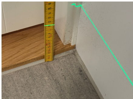
Fallforhold ca. 111 mm overkant gulv ved terskel
