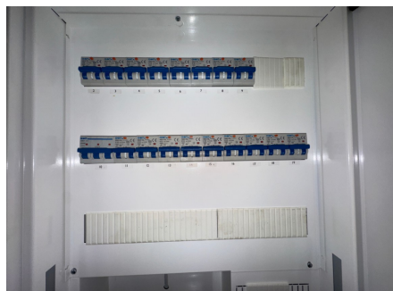
Sikringskap hoveddel
