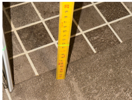
Fallforhold ca. 115 mm overkant gulv ved dusjsone
