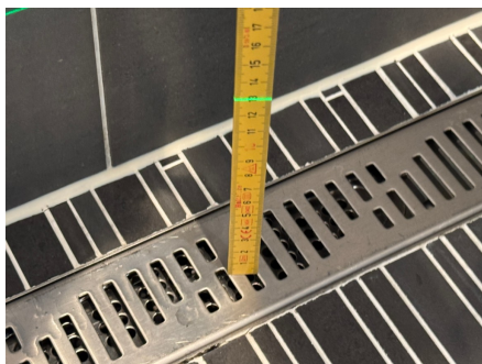
Fallforhold ca. 130 mm topp slukrenne ved vegg i dusjsone
