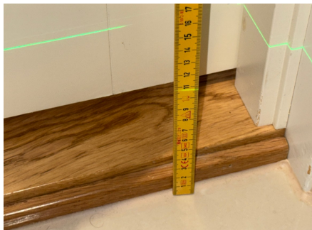
Fallforhold ca. 106 mm overkant gulv ved terskel
