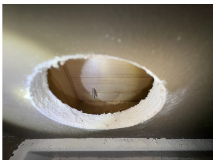
Hulltaking i tilstøtende soverom
