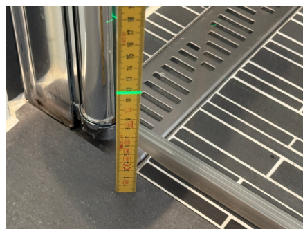
Fallforhold ca. 118 mm overkant gulv ved dusjsone
