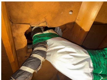
Fuktskjolde og skade undertak
