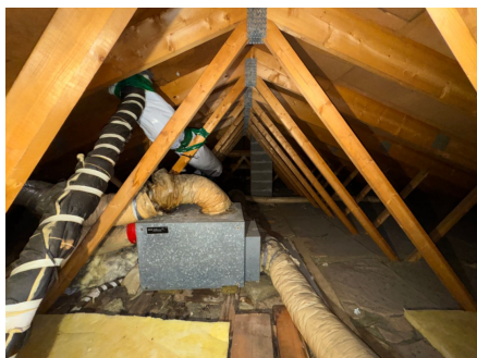
Fuktskjolde og skade undertak
