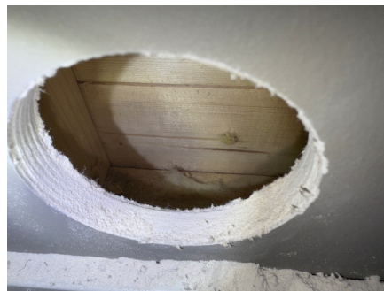
Hulltaking i tilstøtende soverom
