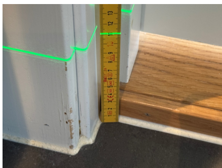
Fallforhold ca. 110 mm overkant gulv ved terskel
