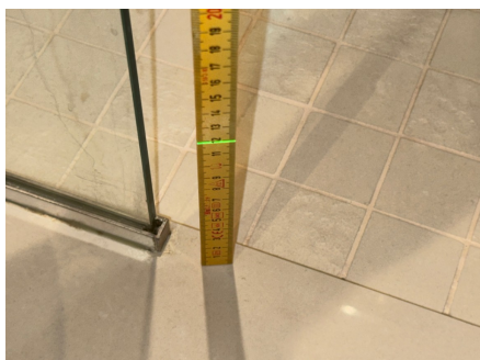
Fallforhold ca. 120 mm overkant gulv ved dusjsone
