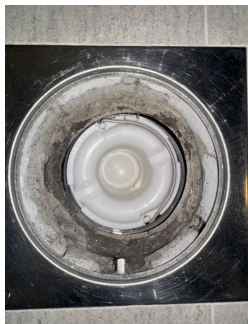
Plastsluk med klemring og synlig membran/mansjett
