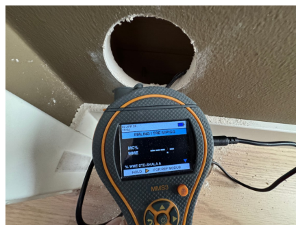
Hulltaking i tilstøtende soverom
