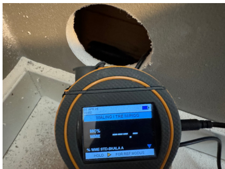
Hulltaking i tilstøtende soverom
