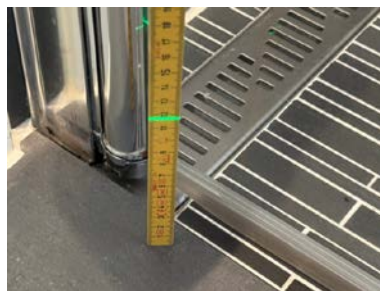
Fallforhold ca. 118 mm overkant gulv ved dusjsone
