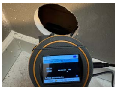
Hulltaking i tilstøtende soverom
