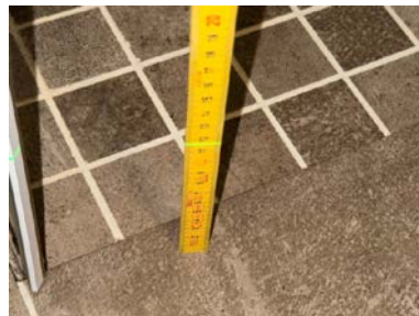
Fallforhold ca. 115 mm overkant gulv ved dusjsone
