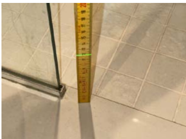
Fallforhold ca. 120 mm overkant gulv ved dusjsone
