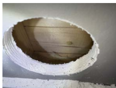
Hulltaking i tilstøtende soverom
