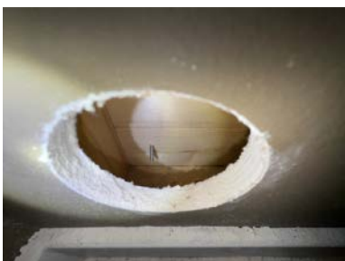
Hulltaking i tilstøtende soverom
