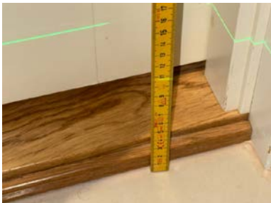
Fallforhold ca. 106 mm overkant gulv ved terskel
