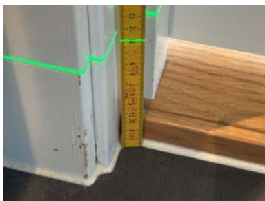
Fallforhold ca. 110 mm overkant gulv ved terskel
