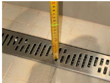
Fallforhold ca. 137 mm topp slukrenne ved vegg i dusjsone
