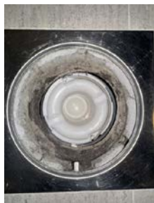
Plastsluk med klemring og synlig membran/mansjett
