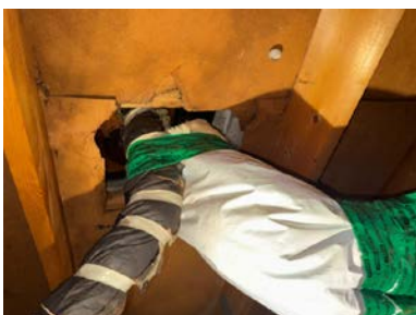
Fuktskjolder og skade undertak
