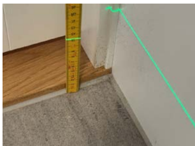
Fallforhold ca. 111 mm overkant gulv ved terskel
