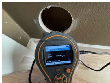
Hulltaking i tilstøtende soverom
