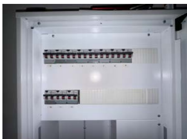
Sikringsskap hybeldel
