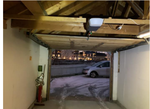
Noe provisorisk opplegg i garasje
