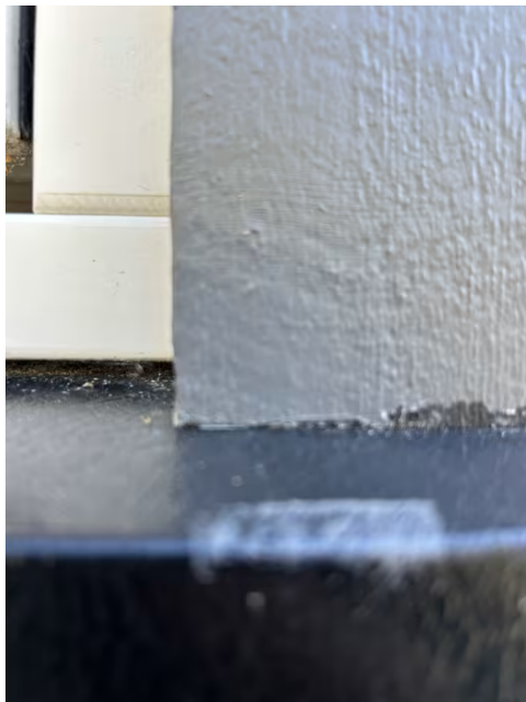
Panel ned til vannbrett.
