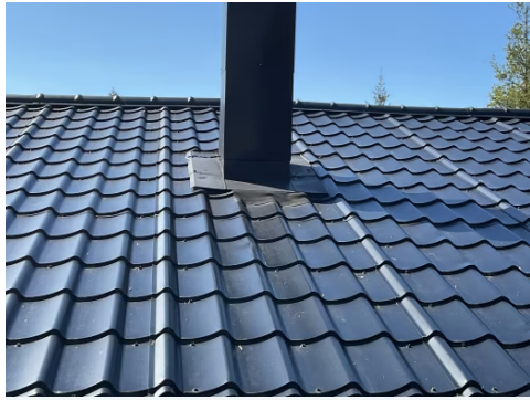
Takplater og beslag pipe.
