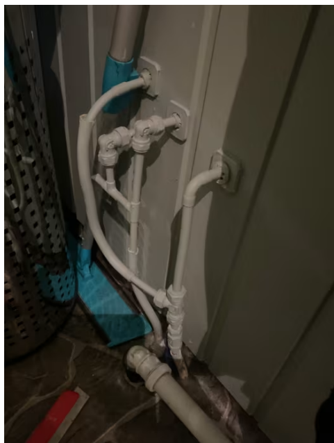
Eldre del av vannledninger.
