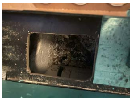
Stoppekran plassert i luke i kjøkkengulvet.
