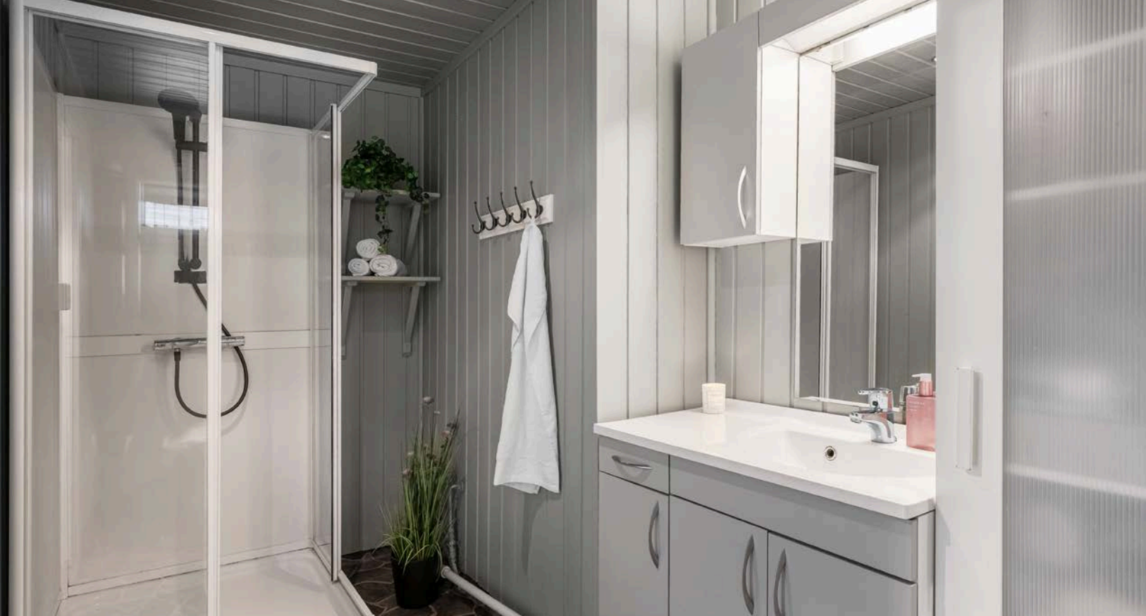
Baderommet som ble bygget i 2007 har belegg på gulv og malt panel på veggene. Badet er utstyrt med servantskap, høyskap og dusjkabinett.
