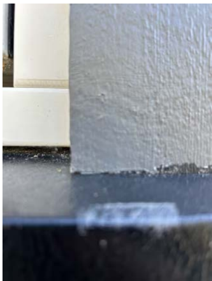
Panel ned til vannbrett.
