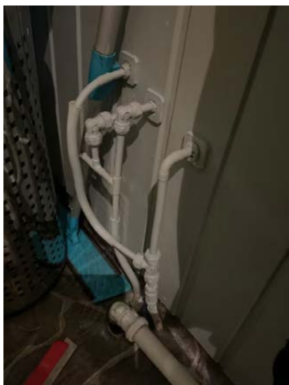
Eldre del av vannledninger.
