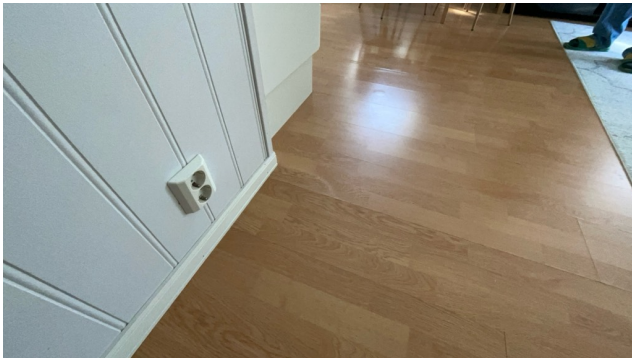
Stedvis svellet laminatskjøter.
