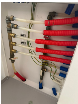
Samleskap med rørkurser og stoppekraner
