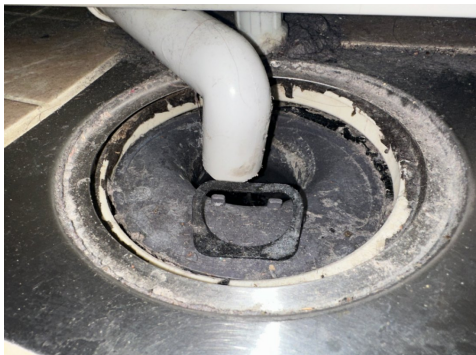
Plastsluk med klemring for membran
