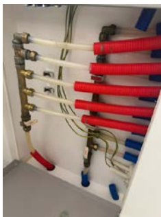
Samleskap med rørkurser og stoppekraner
