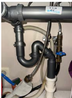
Samleskap med rørkurser og stoppekraner
